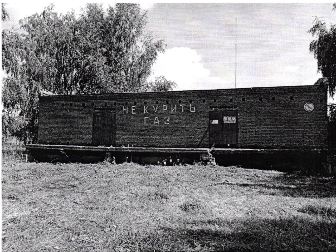
Нежилое строение – Склад хранения баллонов
